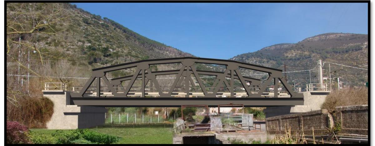
**SPALLE E PILE ESISTENTI:** in muratura, con sezione pseudo-rettangolare a gravità, precedentemente consolidate con fodere in cls
