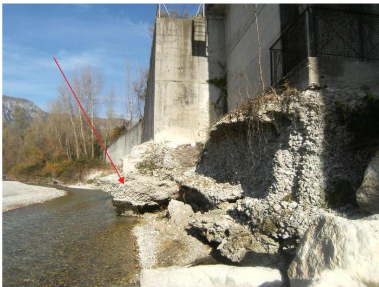
Vista panoramica con evidenziato lo scalzamento verificatosi due pile contigue e vista erosione fondale muro rilevato
