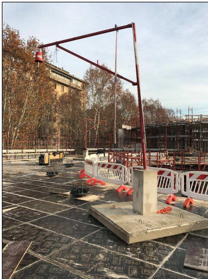
Palo Alsipercha montato su plinto in c.a. trasportabile
