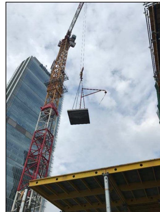
Movimentazione aerea plinto con palo
