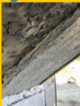
In seguito alla regolarizzazione del supporto con la malta MX-RW Alte Prestazioni, malta tixotropica fibrata per il ripristino della muratura, è stato eseguito un intervento di rinforzo con sistema FRCM in fibre in PBO:
