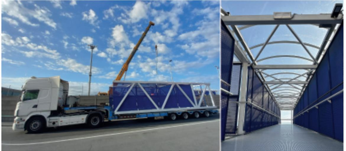
La sua installazione è stata completata durante un'interruzione notturna programmata di 24 ore, mentre il completamento delle opere di adeguamento degli sbarchi è stato eseguito nei giorni successivi, permettendo così di aprire al transito pedonale 7 giorni dopo la messa in opera del nuovo impalcato.
