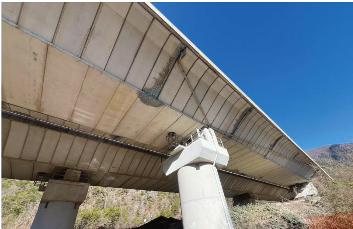
Figura 1 - Viadotto Carnia - Viadotto Carnia: intervento di ripristino del calcestruzzo armato su pile e pulvini con ciclo tecnico di protezione delle armature, ricostruzione del copriferro e protezione superficiale - DRACO®
