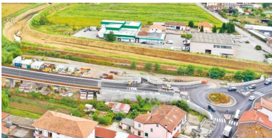
Sopra e pagina a fianco: Cavalcaferrovia su scatolare in c.a. con rilevato in EPS
